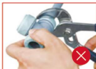
切断水管必须使用专用切割刀,不能使用其他工具以免水管变形。盖帽拧紧的时候不许使用工具。
